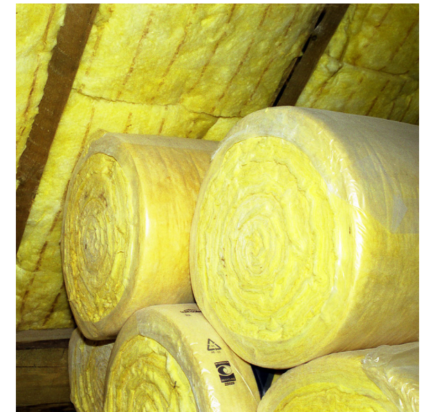
Verbaute Dämmwolle im Dachstuhl eines Hauses
